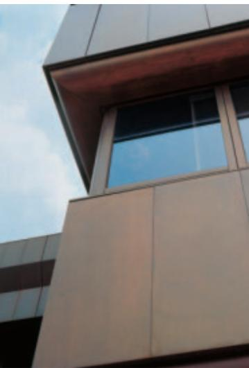
Il rivestimento esterno del quartiere generale della Banca Popolare di Verona è stato realizzato con una facciata ventilata (4000 mq.) realizzata con pannelli sagomati composti da lamiera esterna in lega di rame, brunita con tonalità scura.
